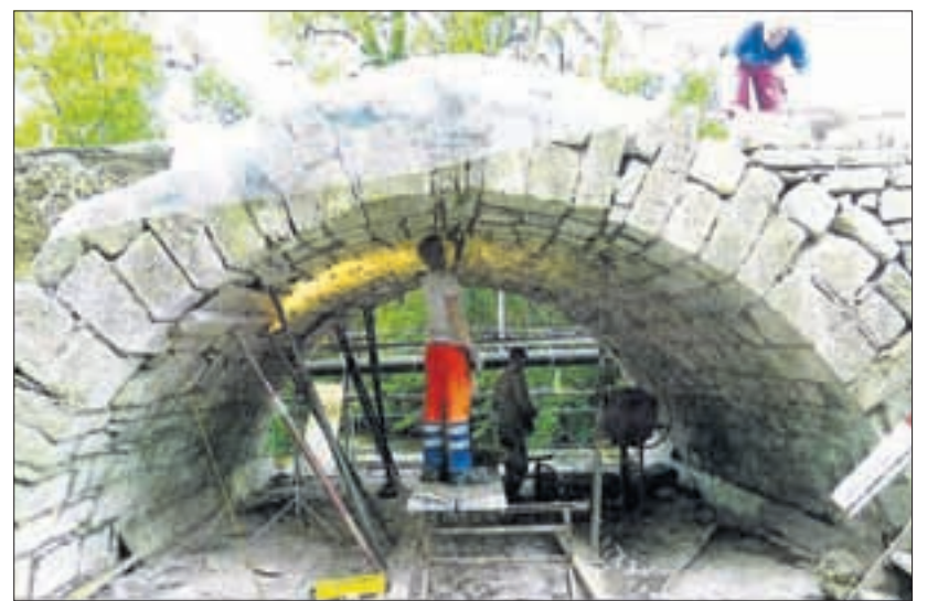
Arbeiter gaben der Sagelibrücke in den vergangenen Tagen den letzten Feinschliff. pd
